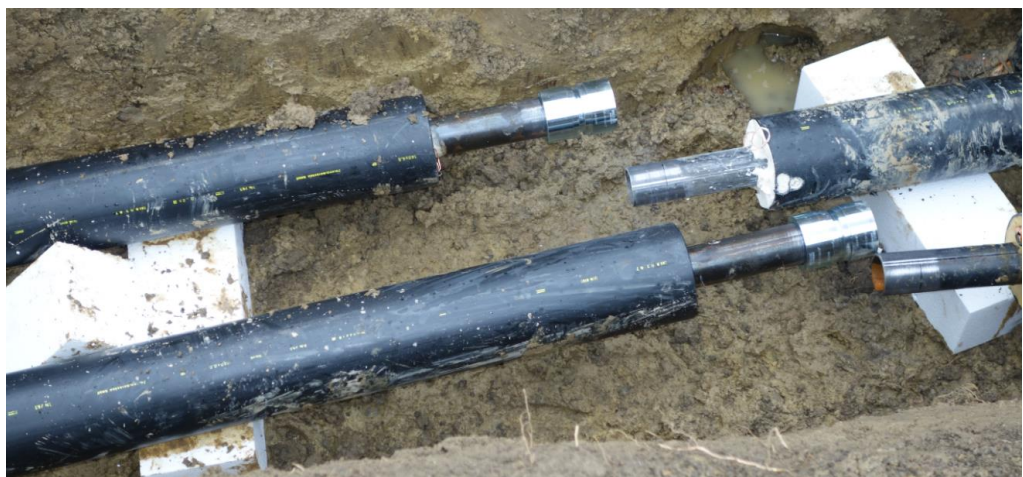
Einseitiges Verpressen vor Rohreinführung
