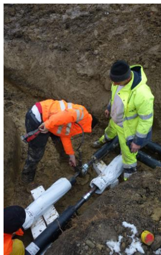
Montage Dehnschenkel
