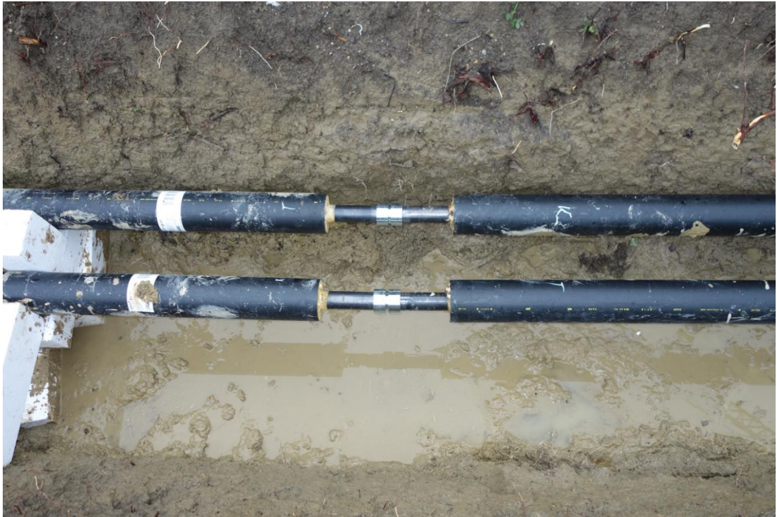
Verpresste Verbindung Vor-/Rücklauf während Druckprobe
