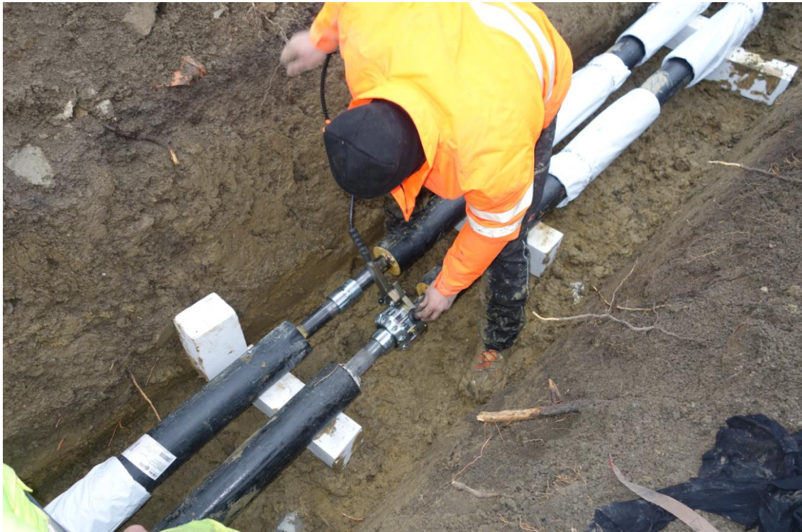
Verpressung (ca. 80 Sekunden pro Pressung) – Akku hielt ohne Nachladung für die gesamte Trasse
